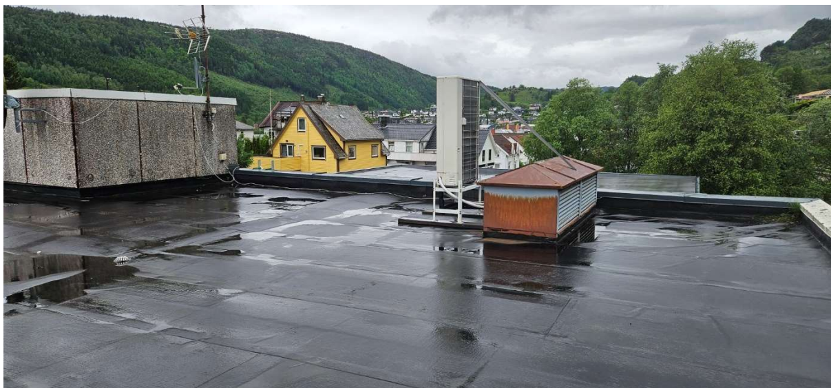
Bilde 3: Oppstikkende heisjakt
