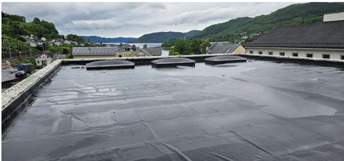
Bilde 1: Eksisterende tak med røyklukene som skal fjernes og tettes igjen.
