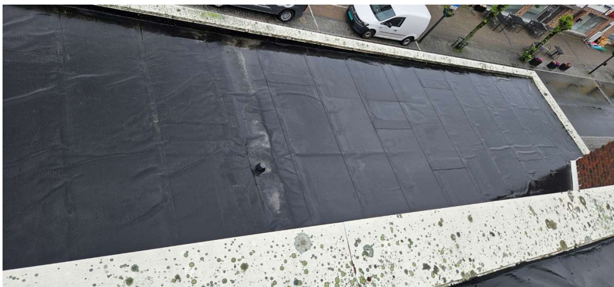
Bilde 4 nedre del av taket.
