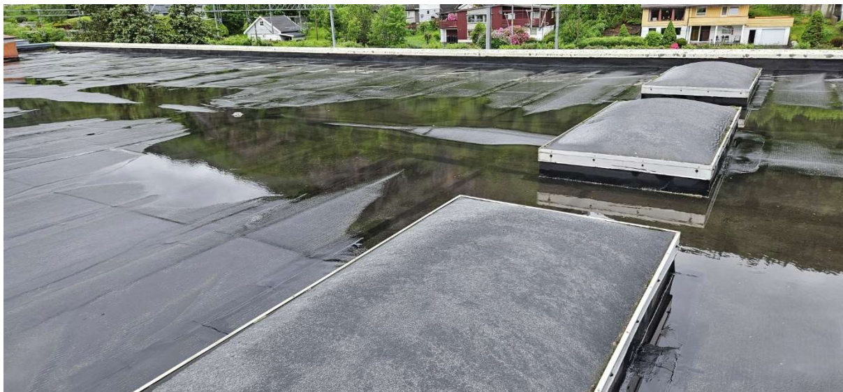
Bilde 2: Røyklukene på eksisterende tak.
